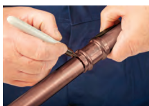
4. Assemblage et marquage de la profondeur d'insertion
