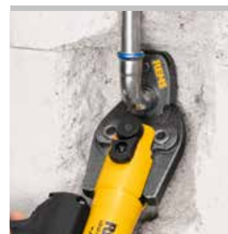
Boucle de sertissage REMS 45° (PR-2B) Brevet EP 2 774 725
