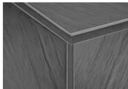
Réalisation d'angles avec coupe en onglet
