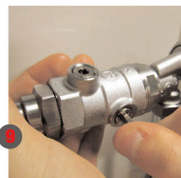
refermez la purge du dessus et ouvrez la vanne sur le côté
