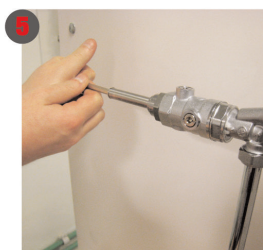
après avoir vissé la clef, enfoncez la tige en la vissant jusqu'à la prise du mécanisme à l'aide d'une clef à laine.
