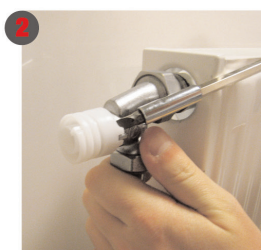
Enlevez la bague en plastique blanche à l'aide d'un tournevis
