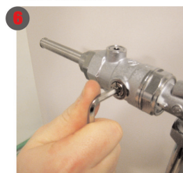
La tige doit ressortir avec la pression du réseau ensuite fermez la vanne d'un quart de tour
