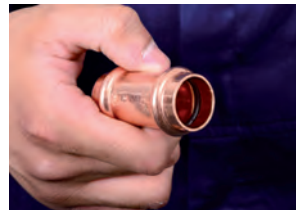
3. Vérification du joint torique
