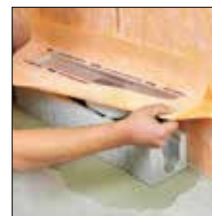
cf. point 2. Mettre en place le corps de caniveau
