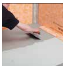
=> 6. Déposer du mortier-colle
