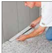
=> 6. Lors du jointoiement, protéger les espaces prévus pour l'évacuation de l'eau autour du support à carreler.
