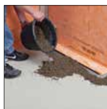
=> 5. Réaliser la chape avec forme de pente
