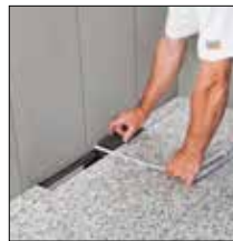
=> 4. Prendre les mesures pour le carrelage du support à carreler...
