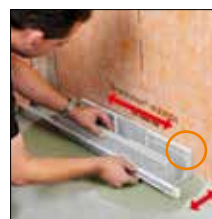
=> 1. Ajuster le support de caniveau
