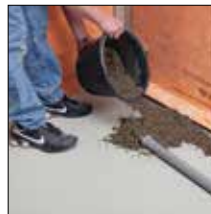
=> 6. Réaliser la chape avec forme de pente
