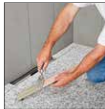
=> 5. Coller le revêtement sur le support à carreler
