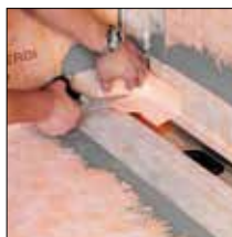
=> 2. Coller la collerette KERDI Découper l'angle rentrant KERECK
