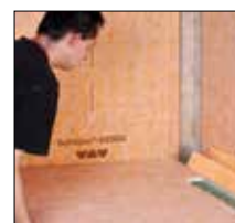
=> 3. Pousser le receveur en pente sous le bord du corps de caniveau
