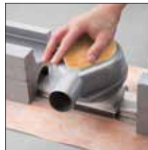
=> 3. Emmancher le corps de siphon sur la pièce de raccord
