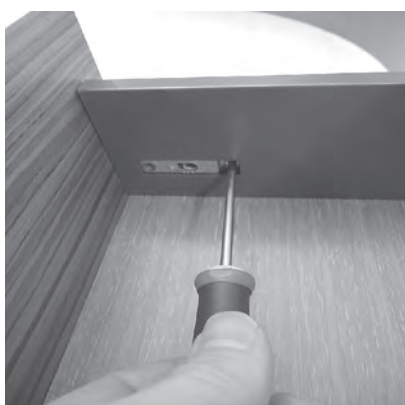
Réglage en hauteur (max. \pm 2 mm) Height adjustment (max. \pm 2 mm) Höhenverstellung (max. \pm 2 mm)
